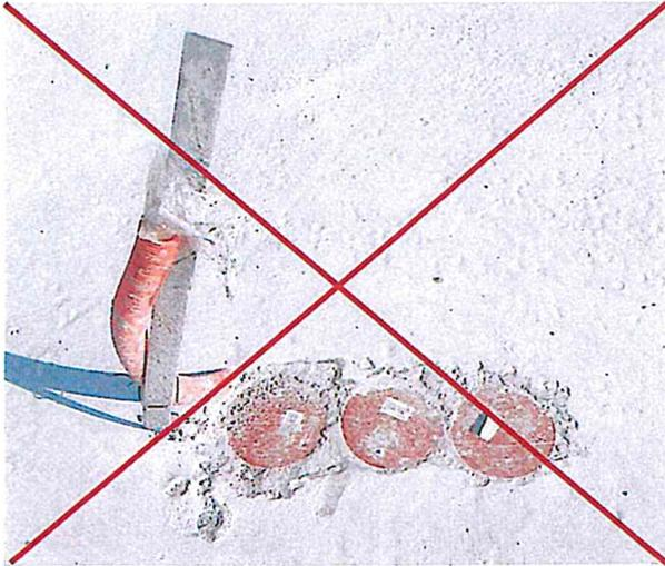
Die Stadtwerke Passau GmbH weist ausdrücklich darauf hin, dass die vielfach verwendeten Einführungshilfen mittels KG- oder HT-Rohre nicht mehr zulässig sind!
